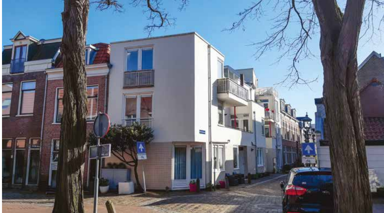
Woningbouw Witte Herenstraat, architect Wiek Röling, 1986-1987
