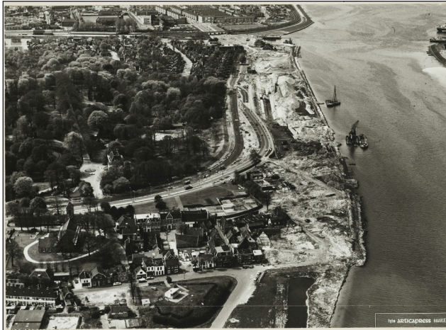
Verbreding kanaal gezien in westelijke richting, 1969. Goed te zien is dat een deel van het dorp wordt gesloopt (NHA)
