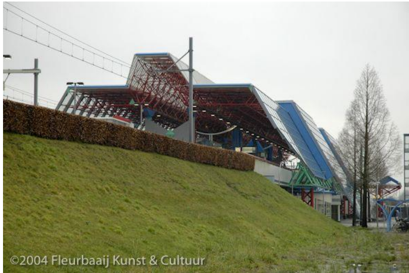
Achterzijde station vóór de verbreding.
