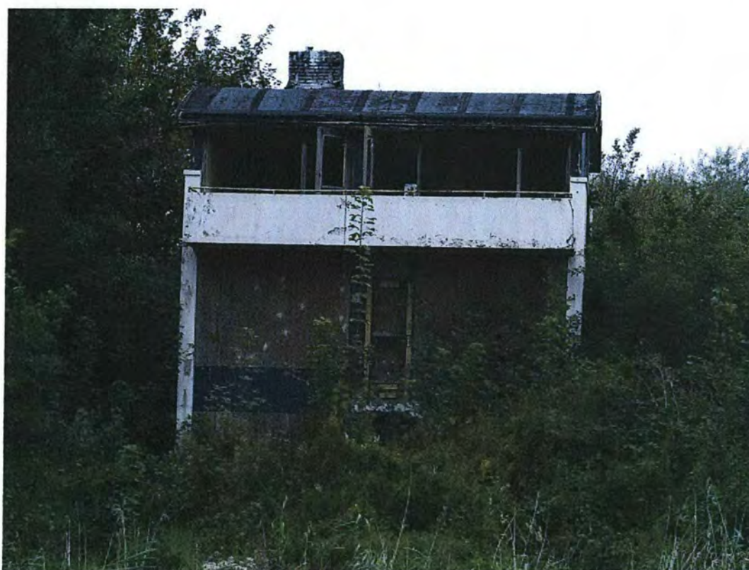
De woningen aan de Karperweg nr. 8 met het bedrijfsgebouw van 3D Metal Forming (boven) en de Karperweg nr. 10, september 2014 (foto's Henk Pruntel).
