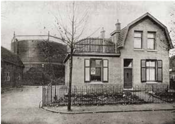
Gashouder van gasbedrijf Zeist in de tuin van de familie van Maren. ca. 1940
