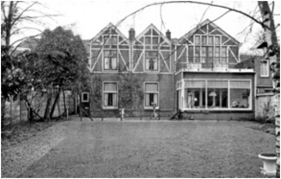
Kerkplein 8 achterzijde jan. 1971
