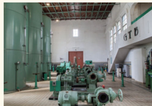
Interieur Pompstation vóór herbestemming
