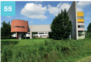
55 Wall House #2 A.J. Lutulistraat 17 Groningen Zaterdag 10.00 - 17.00 Zondag 10.00 - 17.00
