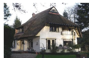
Villa Djoempandang Doornveldlaan 2 3941 ZJ Doorn
