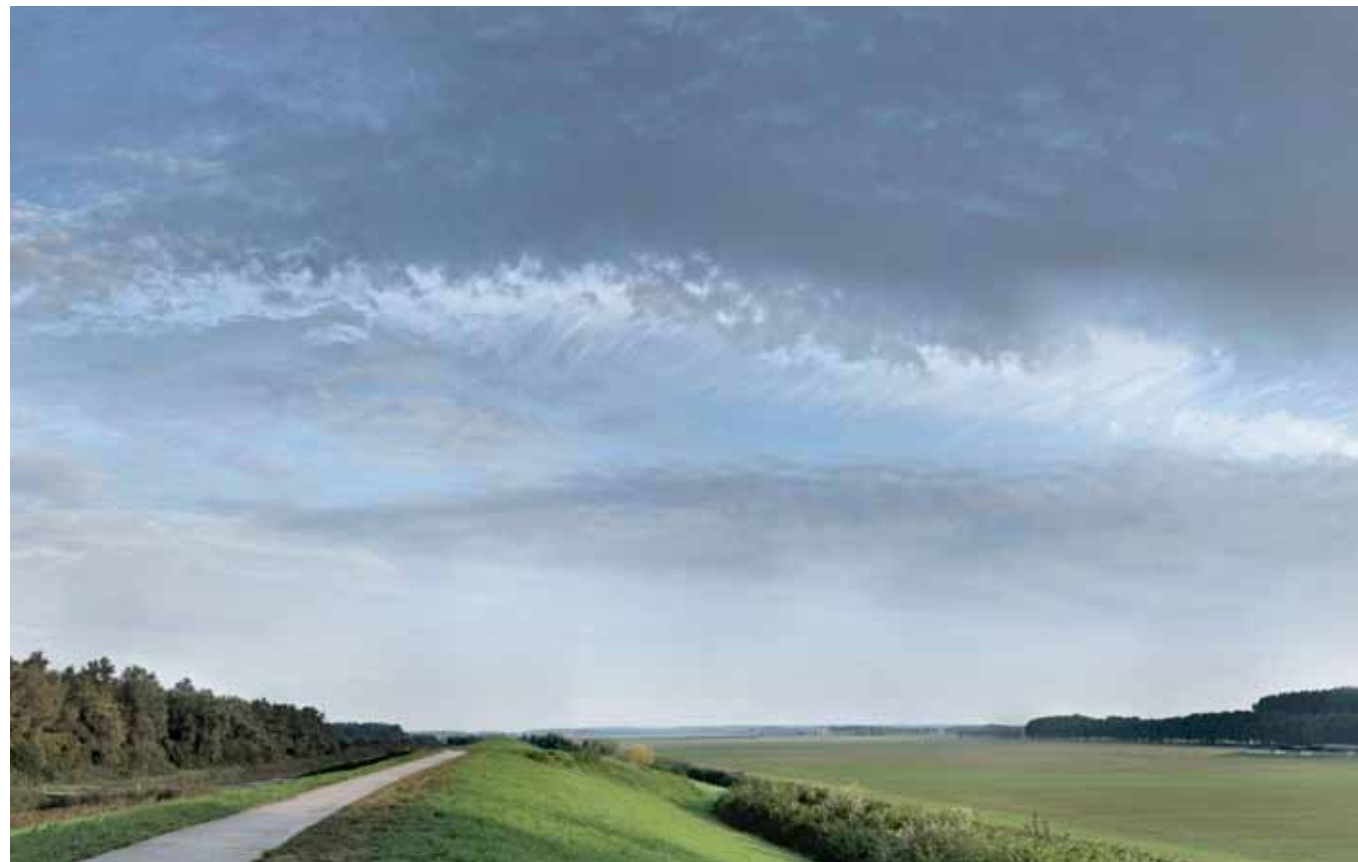
De Knardijk vanaf de werkhaven in westelijke richting
