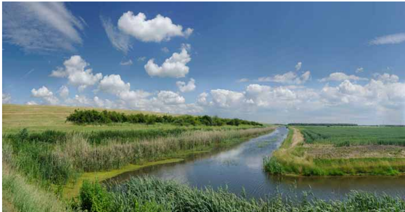
De Knardijk ter hoogte van de Ooievaarsweg.
