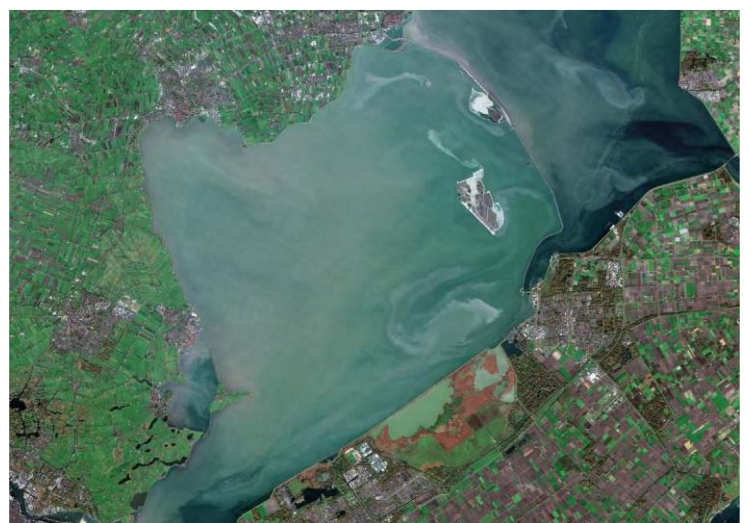
Luchtfoto omgeving Houtribsluizen, Kustvisie L'stad
